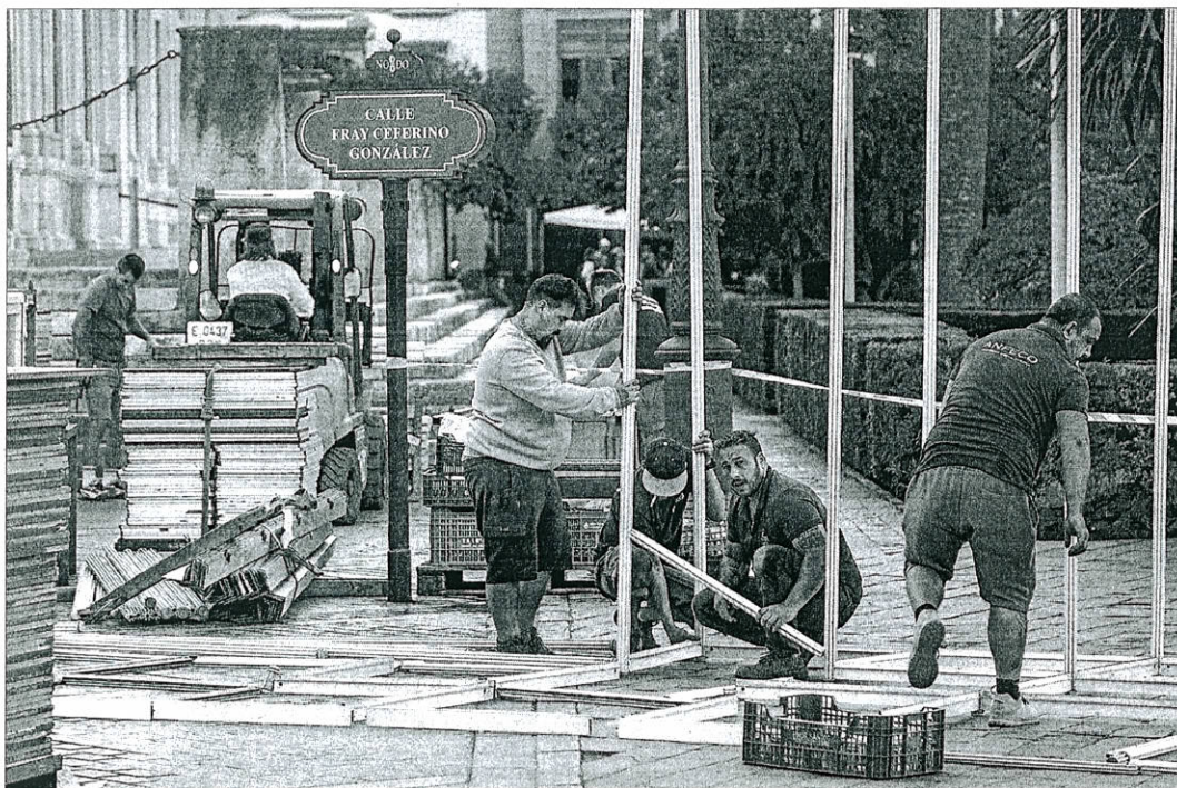
Varios operarios trabajaban el jueves en una calle de Sevilla. / PACO PUENTES
